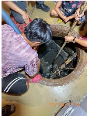
รูปที่ 9 การตัดไขมันจากถังดักไขมัน
