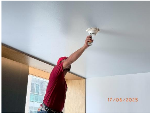
รูปที่ 31 การตรวจสอบระบบป้องกันและเตือนอัคคีภัย
