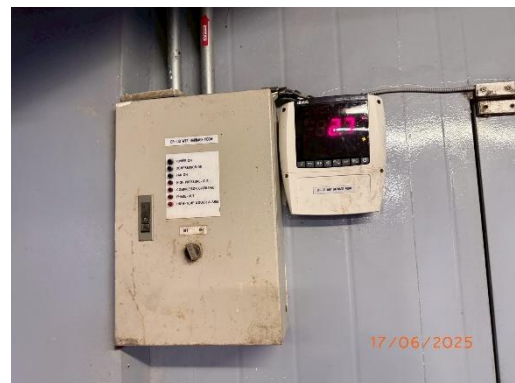
รูปที่ 21 เทอร์โมสแตทห้องพักมูลฝอยรวม
