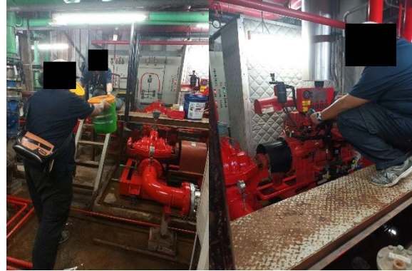
รูปที่ 48 การตรวจสอบ Fire Pump
