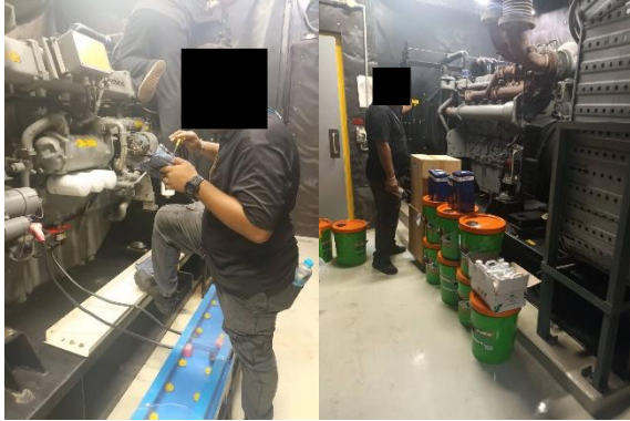
รูปที่ 47 การตรวจสอบระบบจ่ายไฟฟ้าสำรอง
